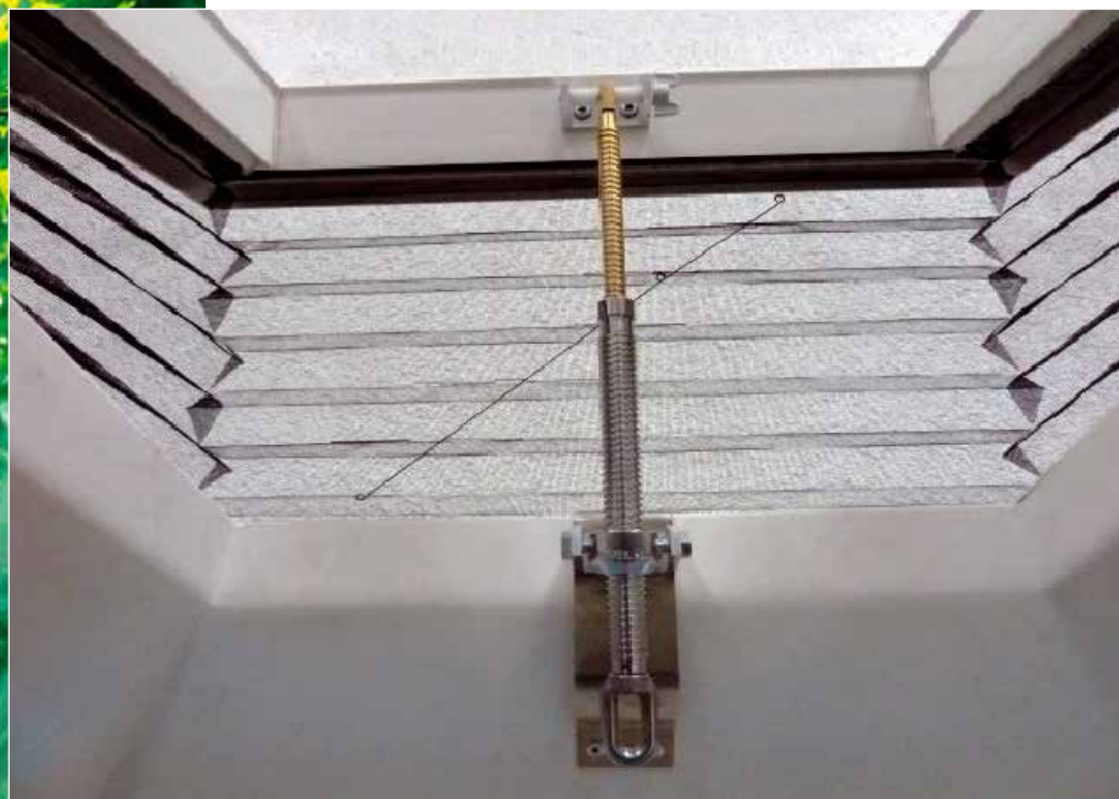
Otvírací světlík se sítí proti hmyzu pohled z interiéru
